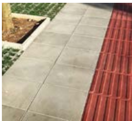
Figura 138. Placa de concreto lisa (sem desenhos) e antiderrapante.
