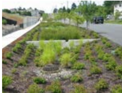
Figura 123. North Kellyville, Austrália. Vala de infiltração.
