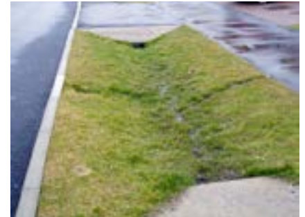
Figura 124. North Kellyville, Austrália. Vala de infiltração.
