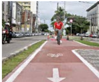
Figura 5. Ciclovía Jornalista Graça Araújo, em Recife, separada da via por meio-fio e faixa de grama.
