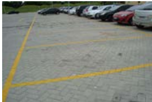
Figura 19. Piso intertravado permeável.
