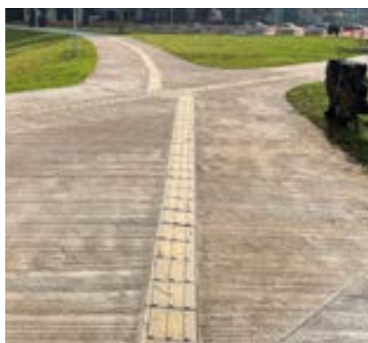
Figura 139. Concreto moldado in loco .
