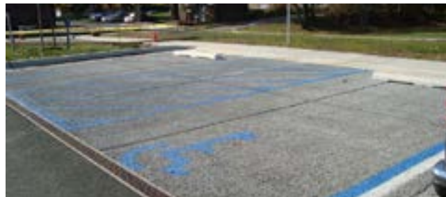
Figura 23. Piso de concreto permeável.
