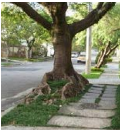
Figura 136. Flamboyant: Raízes superficiais acabam destruindo a calçada do entorno.
